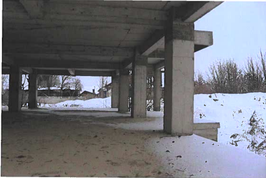
situatie existenta cladire
