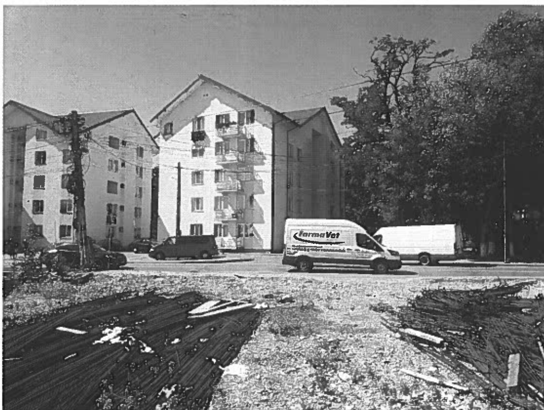
FOTO 5. Vedere dinspre acces spre intersecție
